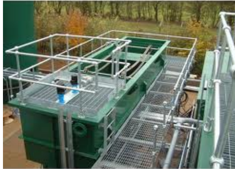
Separatore completo di vasca e pacchi lamellari.
